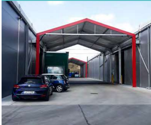
Minden problémára megpróbálunk megoldást találni. Ennek az ügyfélnek egy tetőzetet készítettünk két csarnokhajó összekötéséhez.
