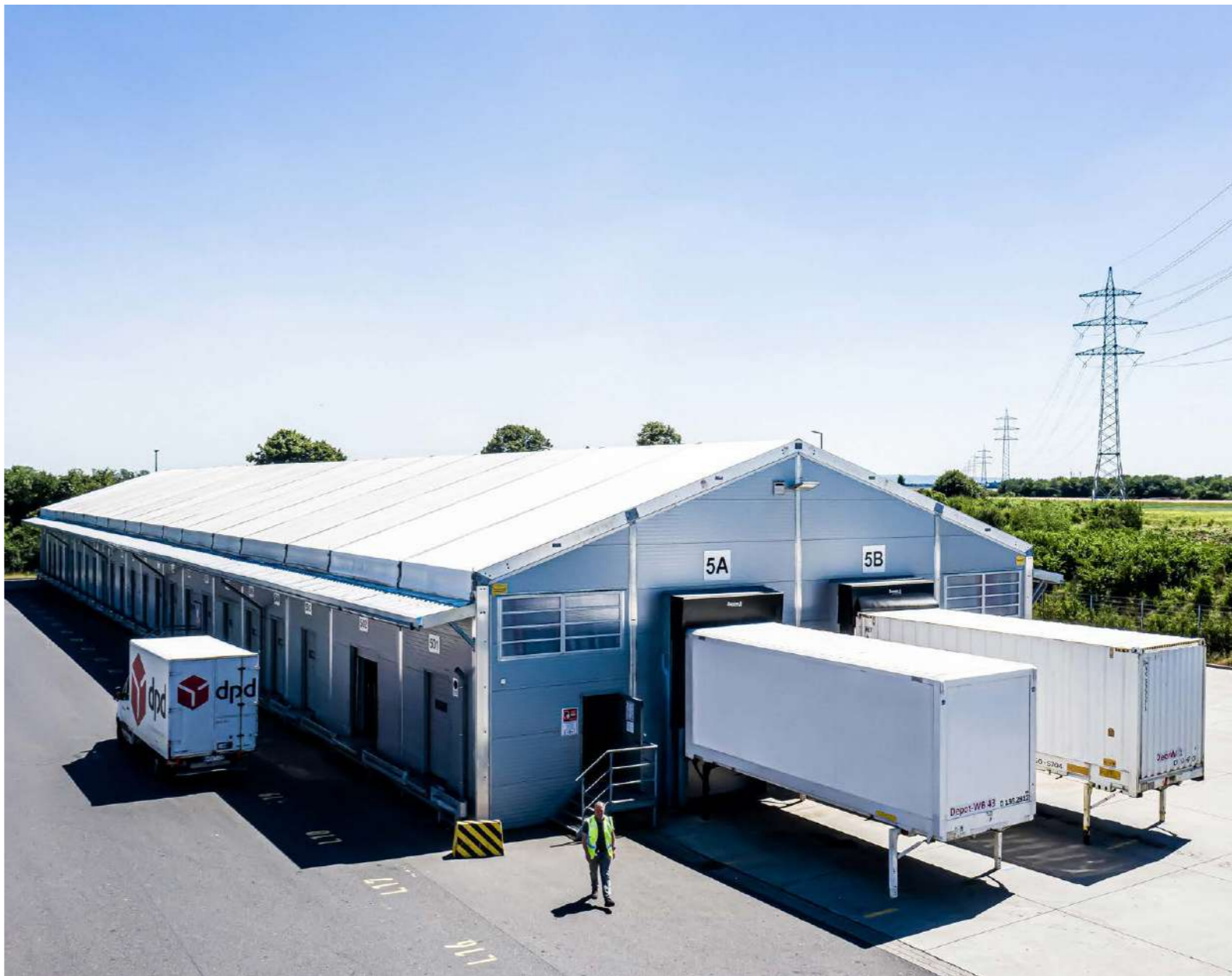
Az egyik nagy autóiipari ügyfelünk számára komplex, többfolyosós csarnokot készítettünk előtetőszerkezetekkel és tolókapukkal.
