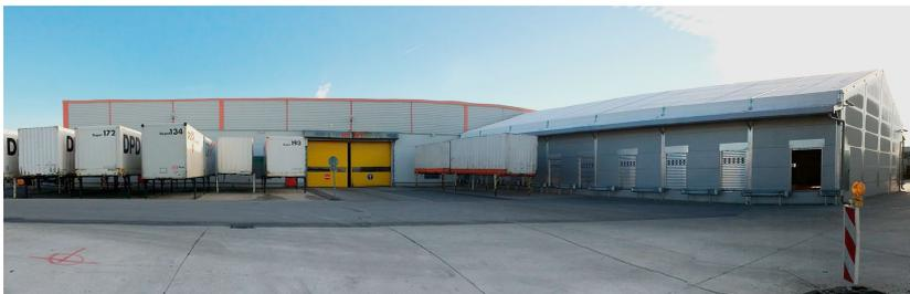
Bâtiment modulaire isolé monté sur de l'enrobé (parking) pour une extension rapide d'une plateforme de distribution. Pose de 20 portes à lames, protections anti-collision et auvent latéral pour une fonctionnalité maximale. Structure accolée par un pignon pour une intégration directe à l'existant.
