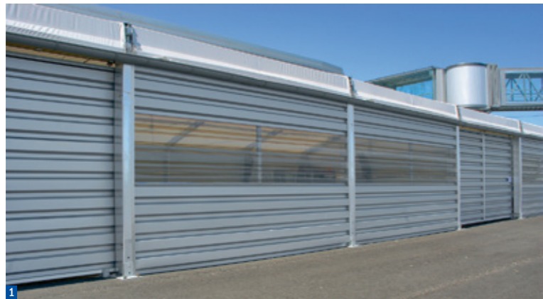
1-2 Transparente Kunststoffpaneele sind eine kosteneffiziente und leicht montierbare Lösung für zusätzlichen Lichteinfall in Trapezblechhallen.
