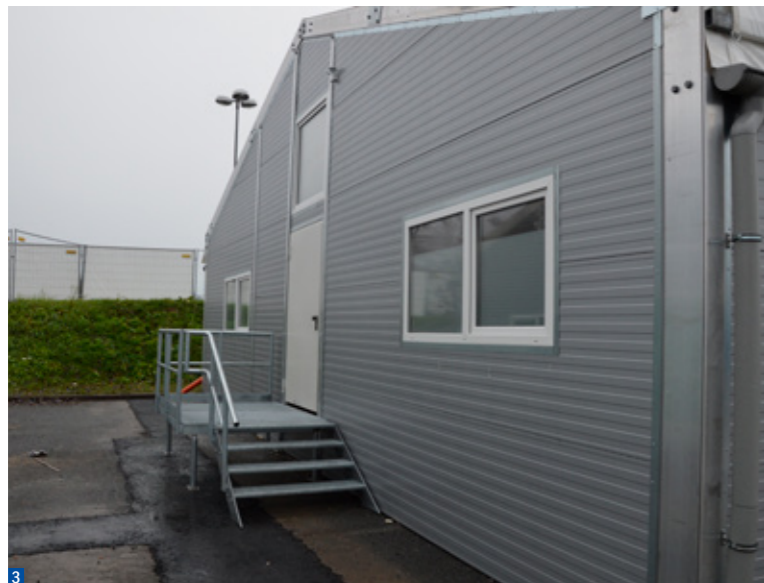
3-4 Zweiflügelige Dreh-Kipp-Fenster in einer Giebelwand mit Iso-Paneeelen. In die Halle ist eine mehrere 100 m 2 große Büroeinheit mit Eingangsbereich bestehend aus einer dreiflügeligen Glastür und einem Vordach aus Stahl eingebaut.
