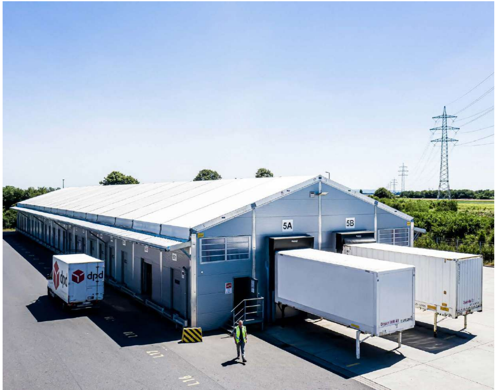
Pour un gros client du secteur automobile, nous avons réalisé un projet complexe composé de plusieurs bâtiments avec auvents et portes coulissantes.
