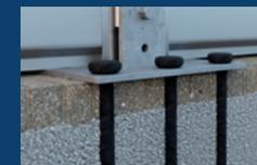
Pour un ancrage à l'aide de pitons acier, la couche supérieure, la couche inférieure et la couche de protection antigel doivent avoir une épaisseur globale d'au moins 80 cm.
